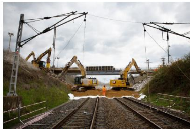
Abgesenkte Oberleitung (OLA), Sicherung Gleisbereich mit Fallbett aus Kies
