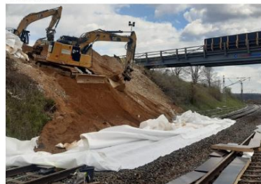
Rückbau Fallbett und Gleissicherung, Verwahrung OLA im Baubereich
