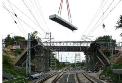
Abbruch Bauwerk (Herausheben eines geschnittenen Mittelteils)
