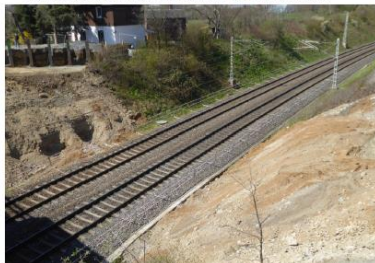
Strecke mit fester Absperrung vor Herstellung Gründung / Widerlager neu
