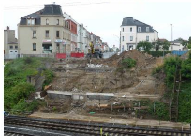
Strecke mit fester Absperrung, Restabbruch Böschungsbereich
